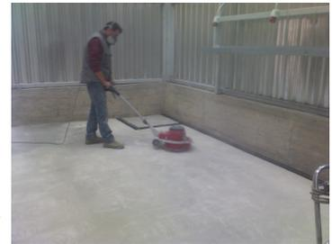
*Inicio: Preparación de la superficie mediante desbaste y lijado*
