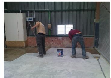
*Proceso: Saneamiento, reparación y aplicación de puente de unión.*
