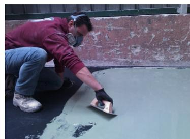
Proceso: Aplicación de mortero autonivelante conductivo.
